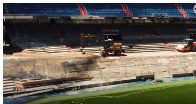
MODERNIZACIÓN DE LAS INSTALACIONES DEL TERRENO DE JUEGO
